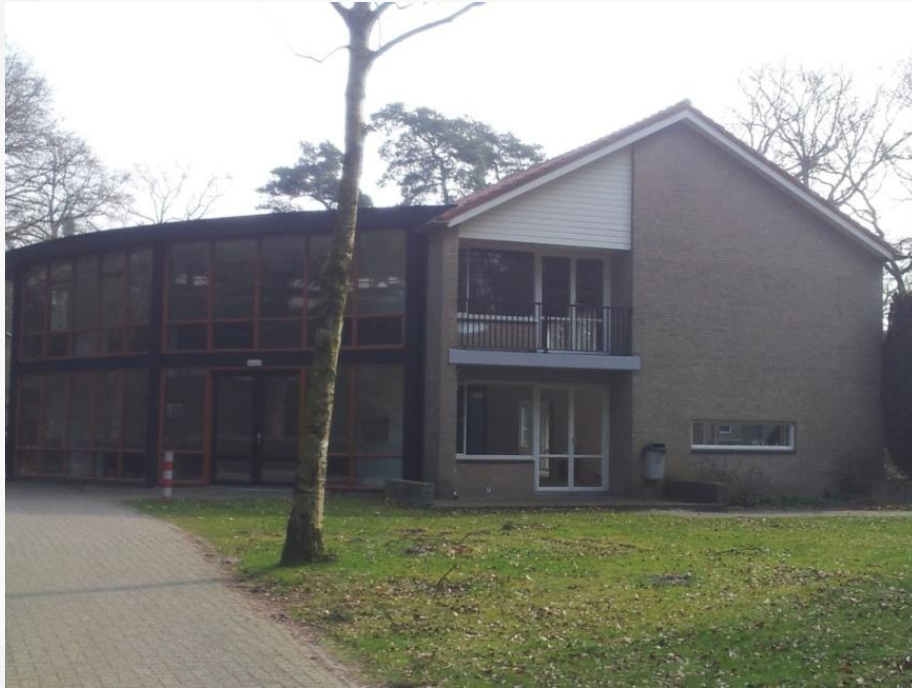
Gebouw 26 voor de verbouwing
